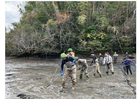
吸い込み口に泥を寄せる作業
