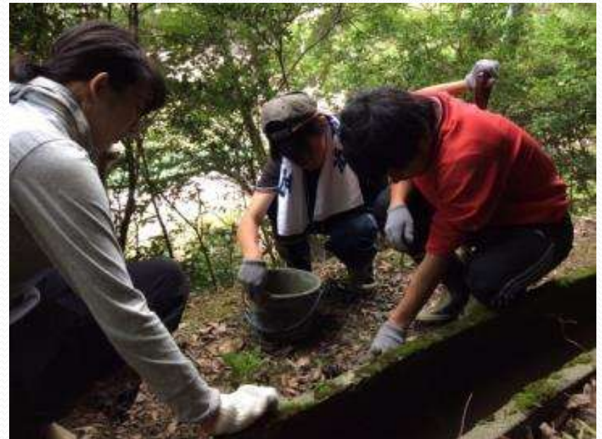
小水力発電導水路の補修
